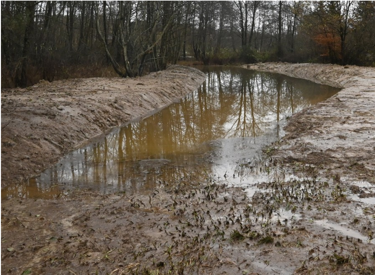
Slika 2. Nova mlaka v k.o. Kančevci po izkopu
