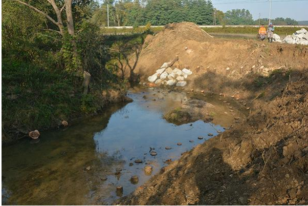
Slika 56 : Utrjevanje brežin v k.o. Šalovci
