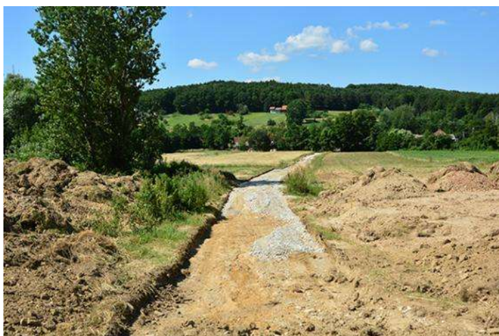
Slika 71: Gradnja novih poti na komasacijskem območju k.o. Prosenjakovci (foto: K. Malačič)
