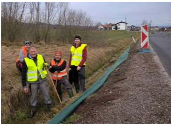
Slika 55: Postavljanje varovalnih ograj
