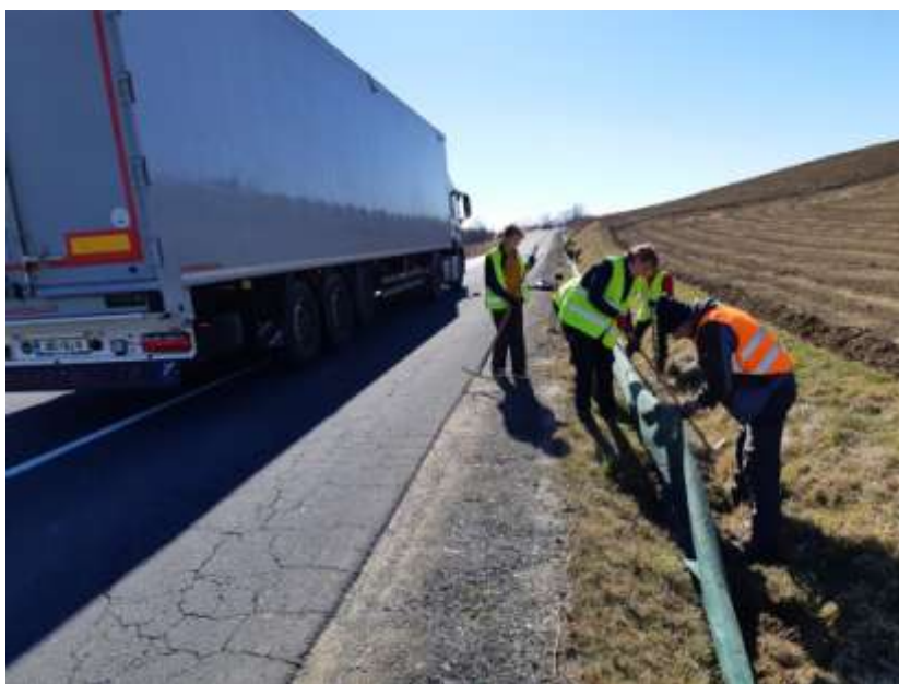
Slika 54: Postavljanje varovalnih ograj ob regionalni cesti (foto: K. Malačič).
